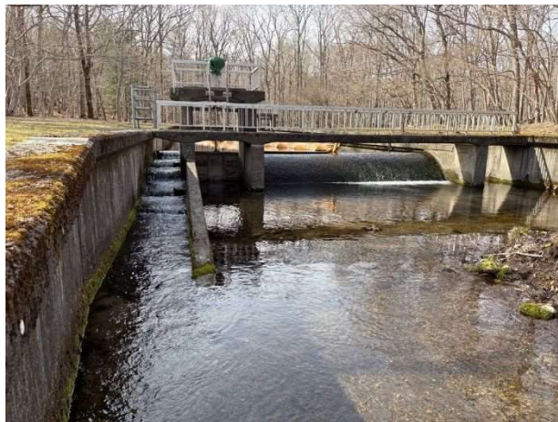
高丘浄水場取水堰堤の魚道
