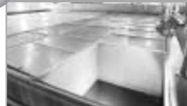
原水に薬品を入れ、かくはんします。すると原水に含まれる濁りに薬品が吸着し、フロック（浮遊物の集合体）を形成します。
