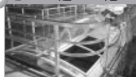
塩素を加え、ろ過装置を通して水道水が完成します。写真の窓の下にろ過装置があります。
