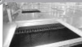
水槽内に斜めに入れてある板にフロックが吸着し、フロックが大きくなると沈殿します。
