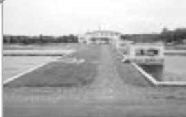
水を砂と砂利の層と微生物のろ過膜に通します。左右に6面の池があります。
