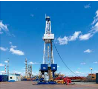
▲石油資源開発(株)苫小牧J-2試掘場
