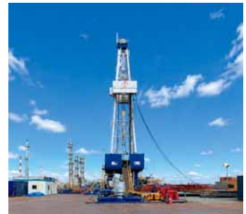
▲石油資源開発(株)苫小牧J-2試掘場
