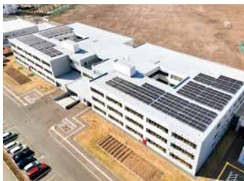
▲苫小牧東小・中学校の屋上に設置した太陽光パネル
