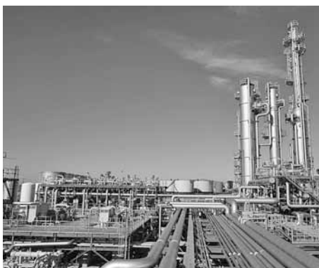
▲苫小牧CCS実証試験プラント(真砂町)
