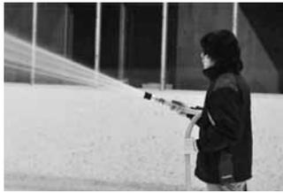
リンク作りは根気のいる作業で、きちんとした氷のためには時間と気温と水温の細かな管理が必要です。急に冷やすとひびが入るし、綺麗な氷にならない。手で何度も水を撒き、2週間以上かけてやっと氷厚45mmのリンクになるんです。一度作ると、今度は毎日のリンク維持に繊細な作業が続きます。整氷車とカッティングマシンで傷のないところまで水
