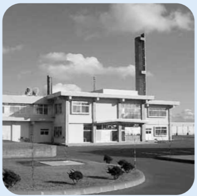
西町下水処理センター
