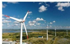
稚内風力発電所
