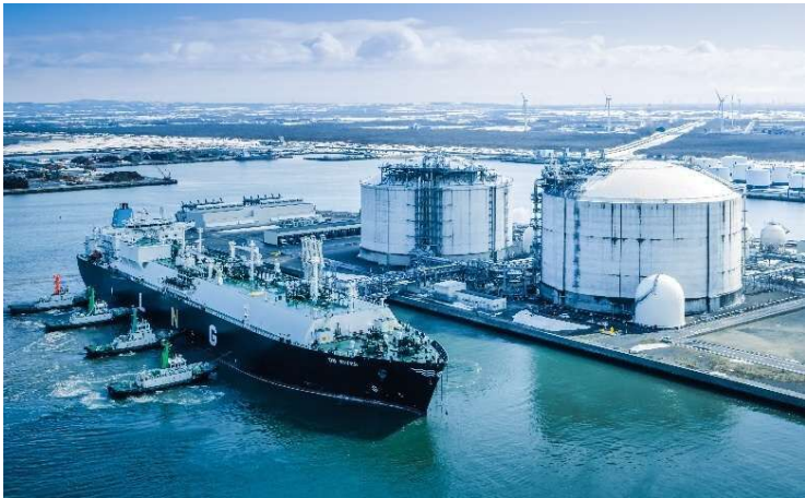
石狩LNG基地
