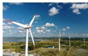
稚内風力発電所
