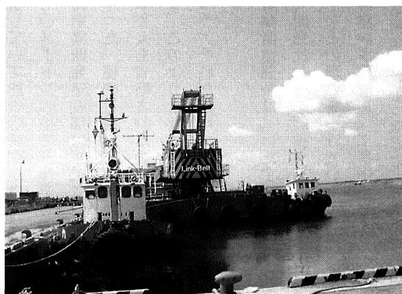
苫小牧港東港の工事作業風景
