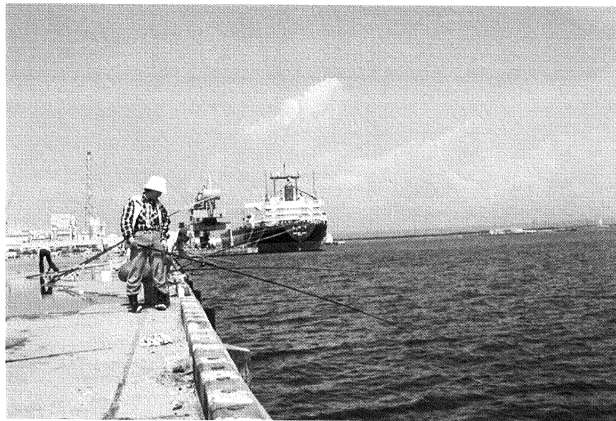
苫小牧港東港区中央埠頭
