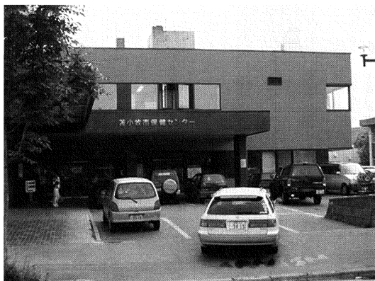
苫小牧市保健センター
