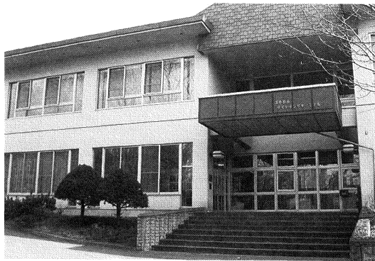
苫小牧市サイクリングターミナル
