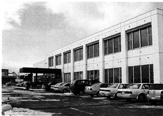
苫小牧市職業訓練センター
