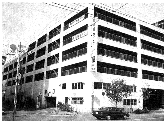
苦小牧駐車場ビル
