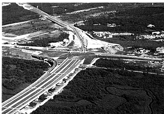
苦東道路沼ノ端ランプウエー
