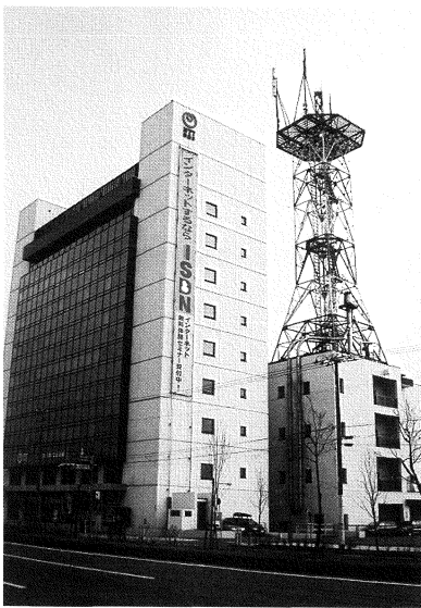
NTT苫小牧支店と中局機械棟
