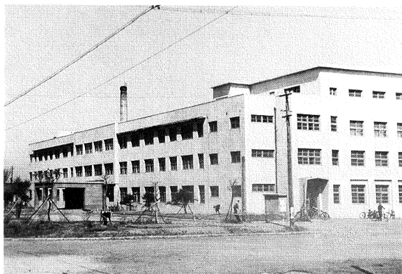
昭和 27 年建築の旧庁舎
