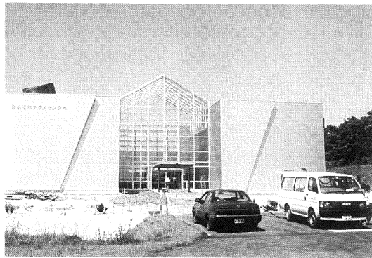
建設中のテクノプラザセンター
