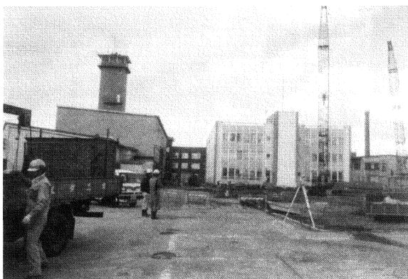
市庁舎増改築工事風景
