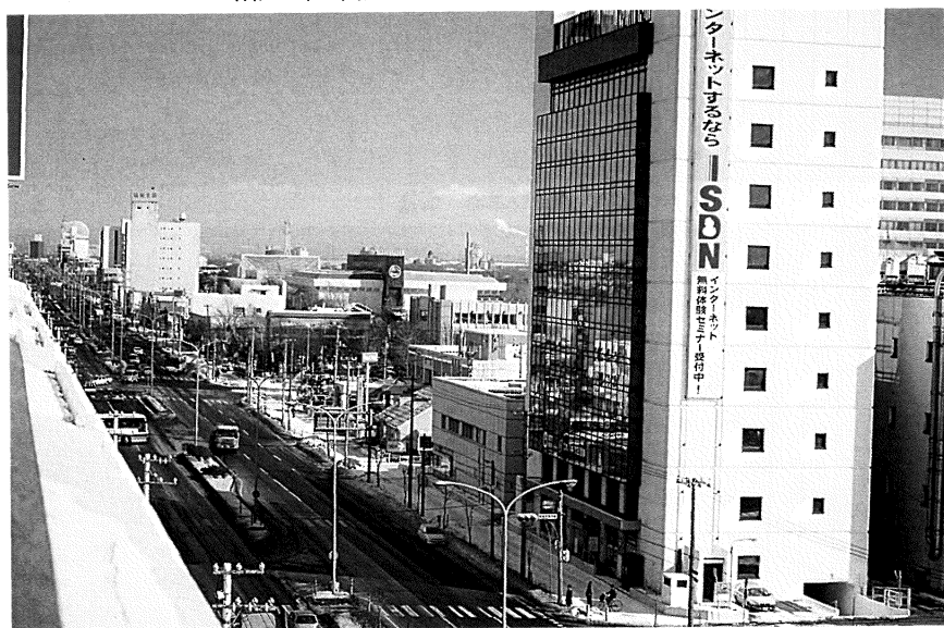
平成13年の国道36号（王子不動産第一ビルより）
