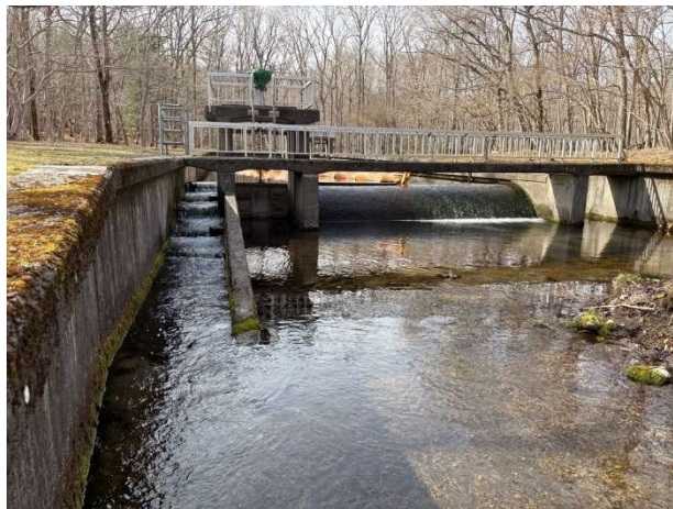
高丘浄水場取水堰堤の魚道
