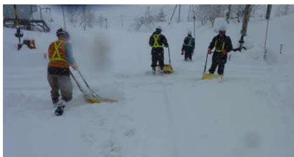
踏切の除雪作業
