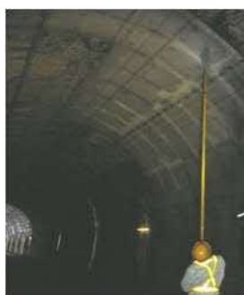
トンネル内のつらら落とし作業
