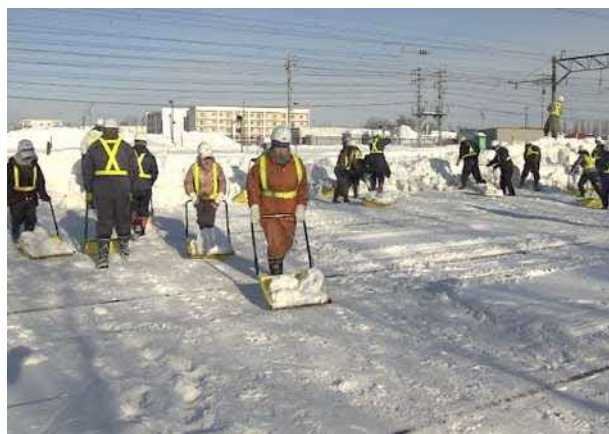
駅構内の除排雪作業
