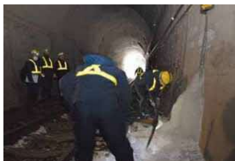
トンネル内の結氷除去作業
