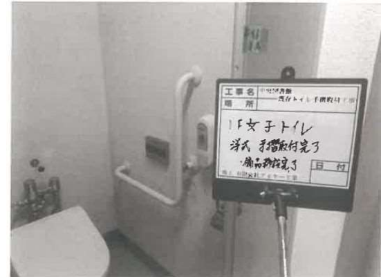
1階女子トイレ完成
