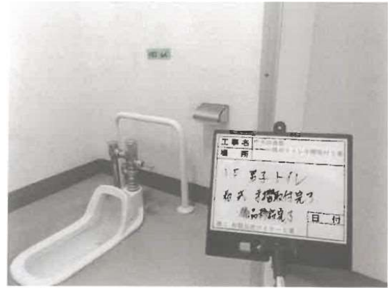
1階男子トイレ完成
