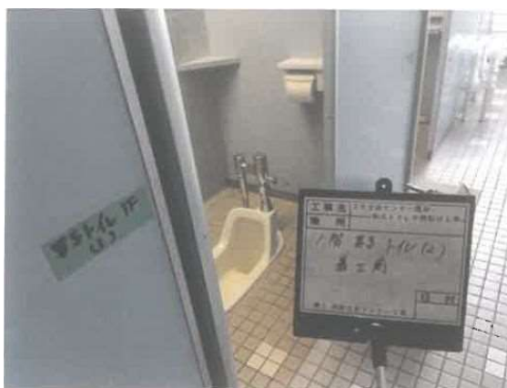
1階男子トイレ着工前
