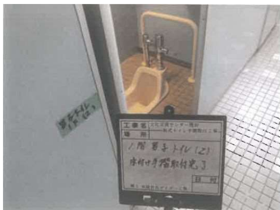
1階男子トイレ完成
