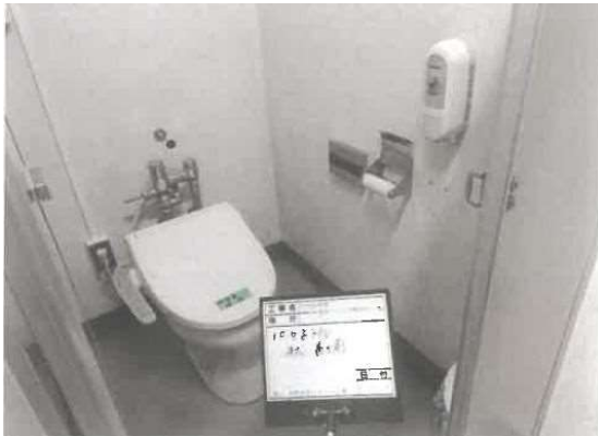
1階女子トイレ着工前
