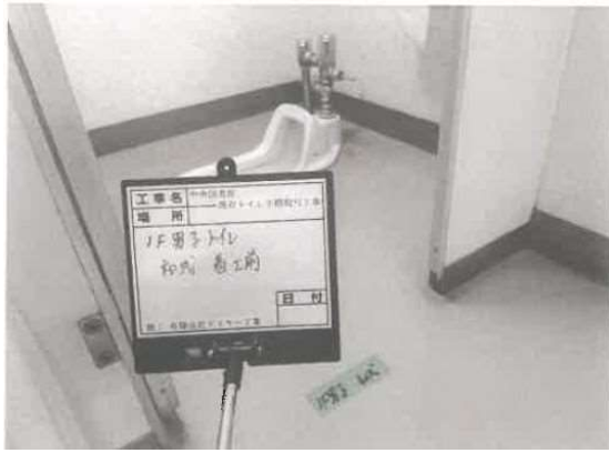
1階男子トイレ着工前
