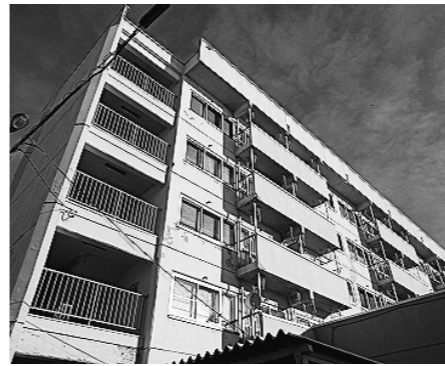
用途廃止の方向性が示された市営住宅
