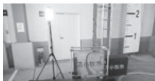
災害用蓄電池と照明器具
