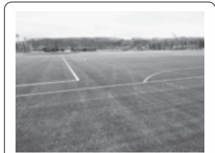
・緑ヶ丘公園サッカー場の照明設備の設置など（9,050万円）
