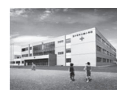
・緑小学校の校舎・屋内運動場の改修工事など（15億3,776万円）
