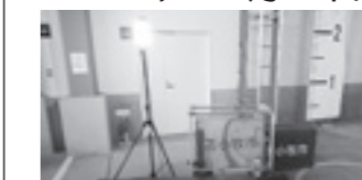
災害用蓄電池と照明器具
