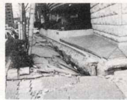
立入注意 (地割れの影響はない)
