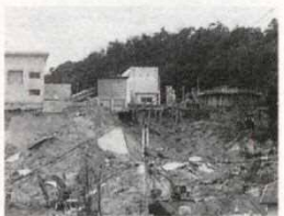
立入禁止(大きく陥没)
