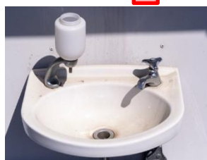
〈自動水洗への改修工事〉
