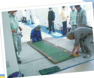
シートの清掃作業
