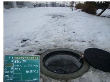
ハンドホール新設【完成】
