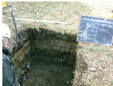
ハンドホール新設【掘削完了】
