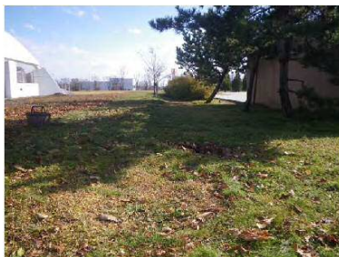
ハンドホール新設【着工前】
