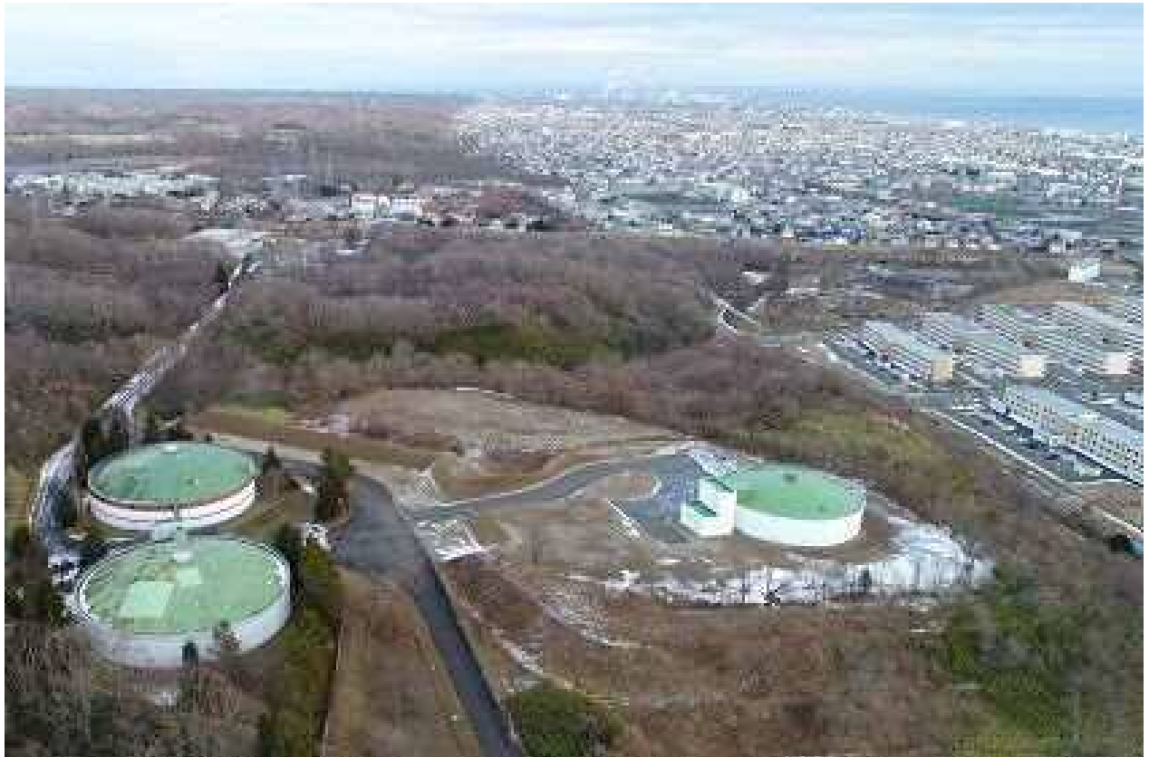
錦多峰配水池上空から市街地を望む
