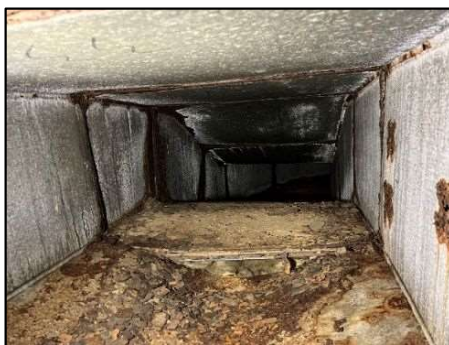
nepiaアイスアリーナ（築29年） 空調機用ダクトの劣化
