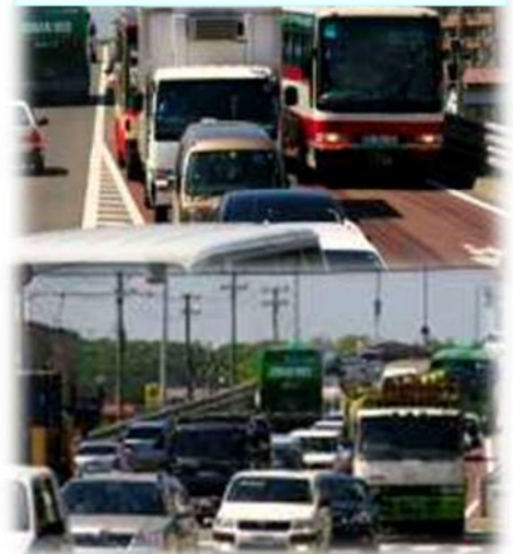
国道276号 緑跨線橋
