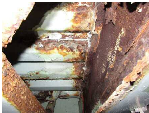
写真-1 横断歩道橋の損傷（桁下）
