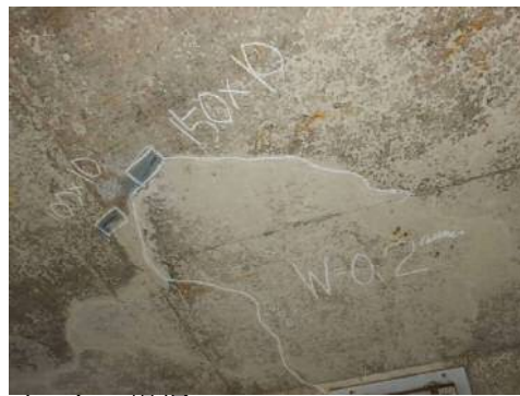
写真-2 大型カルバートの損傷
