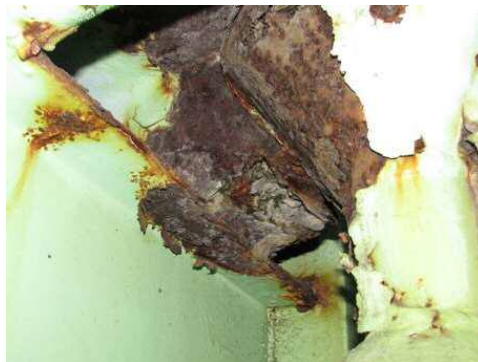
写真-1 横断歩道橋の損傷（桁下）
