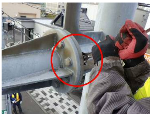
写真-3 門型標識の損傷
