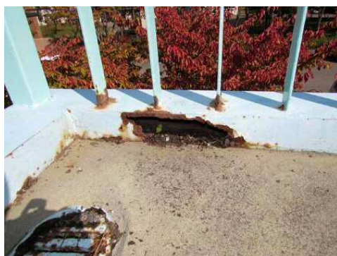
写真-4 横断歩道橋の損傷（橋面）
