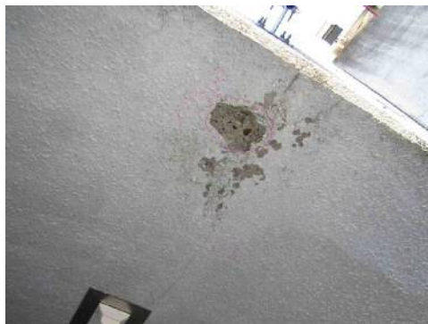
写真-2 大型カルバートの損傷
