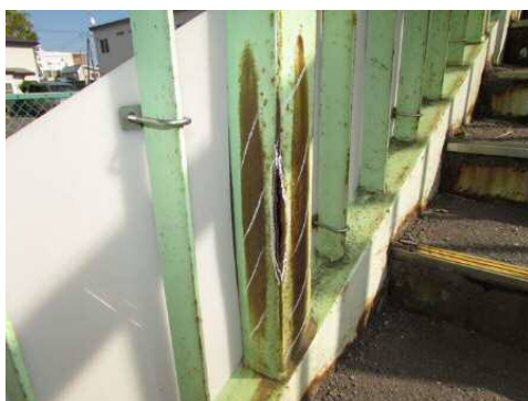
写真-4 横断歩道橋の損傷（橋面）
