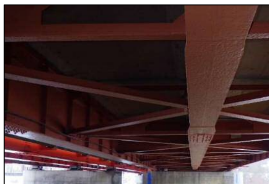
写真-12 鋼桁塗装塗替え後
