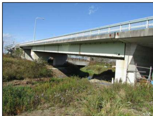
写真-6 かわぞえ跨線橋（複合橋）
