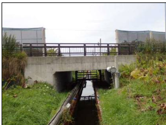
写真-5 王子橋（RC橋）
