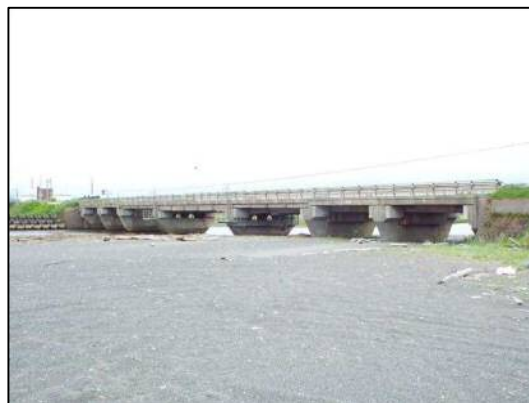
写真-2 勇払橋（橋長85.7m） 昭和28年供用開始（71年経過）
