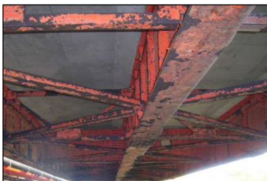
写真-11 鋼桁塗装塗替え前
