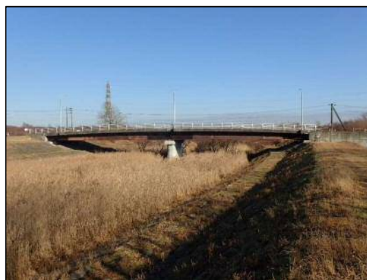
写真-4 新川3号橋（鋼橋）
