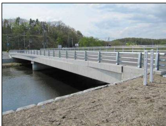
写真-3 新植苗橋（PC橋）
