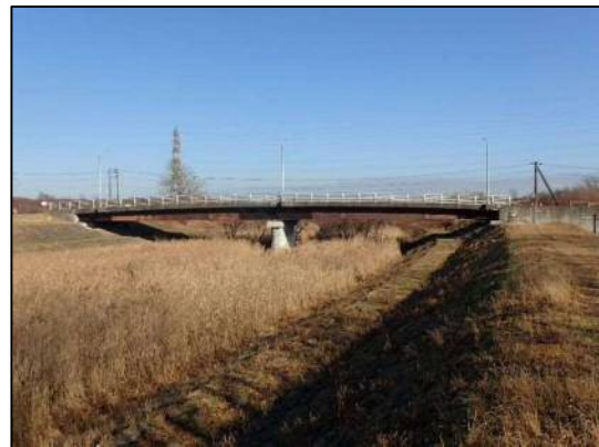
写真-4 新川3号橋 (鋼橋)
