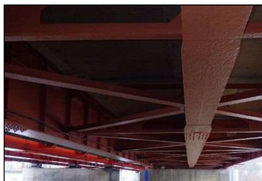
写真-12 鋼桁塗装塗替え後
