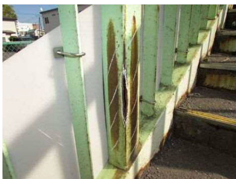
写真-4 横断歩道橋の損傷（橋面）
