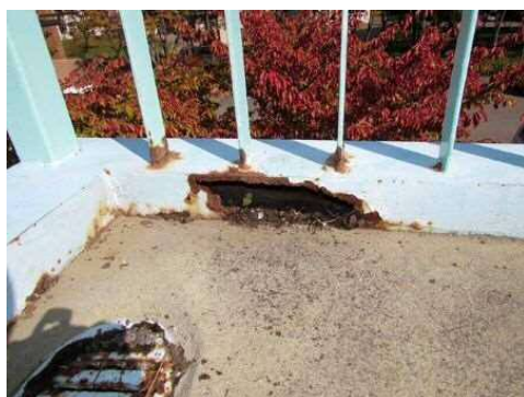
写真-4 横断歩道橋の損傷（橋面）
