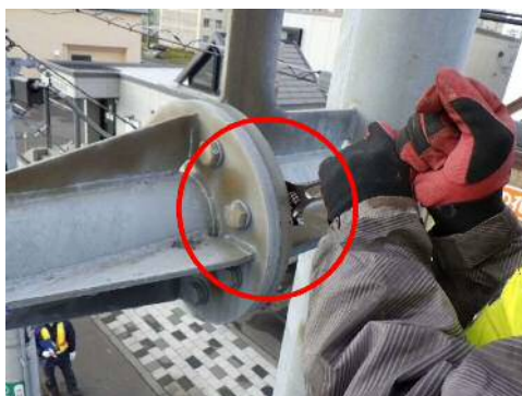
写真-3 門型標識の損傷
