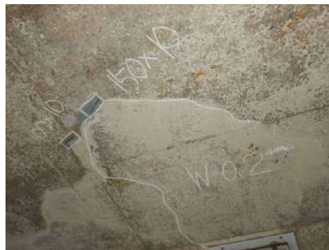
写真-2 大型カルバートの損傷
