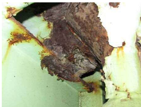
写真-1 横断歩道橋の損傷（桁下）
