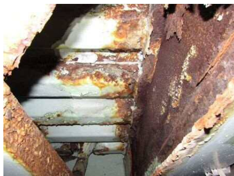
写真-1 横断歩道橋の損傷（桁下）
