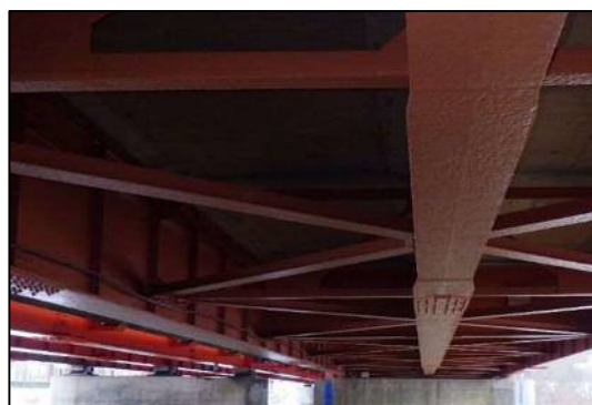
写真-12 鋼桁塗装塗替え後
