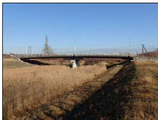
写真-4 新川3号橋（鋼橋）
