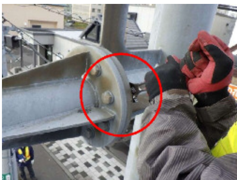
写真-3 門型標識の損傷
