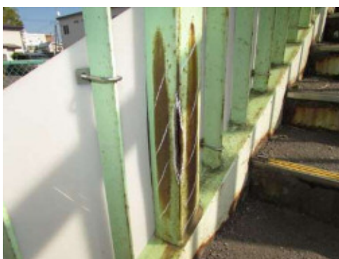
写真-4 横断歩道橋の損傷（橋面）
