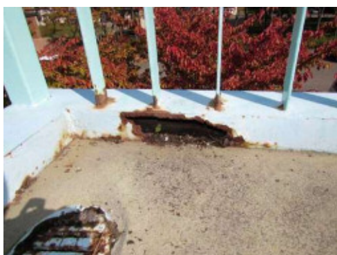
写真-4 横断歩道橋の損傷（橋面）
