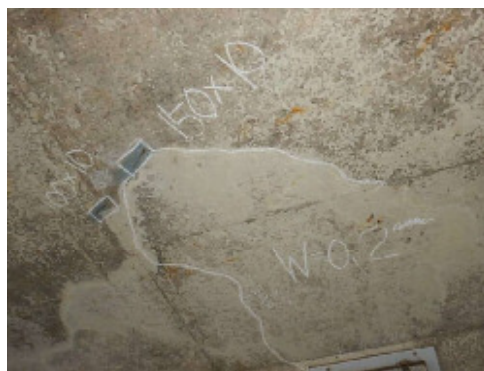
写真-2 大型カルバートの損傷
