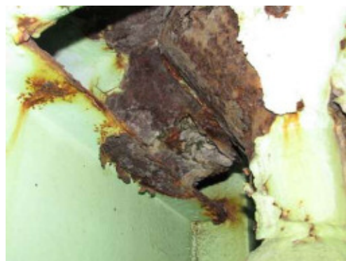
写真-1 横断歩道橋の損傷（桁下）
