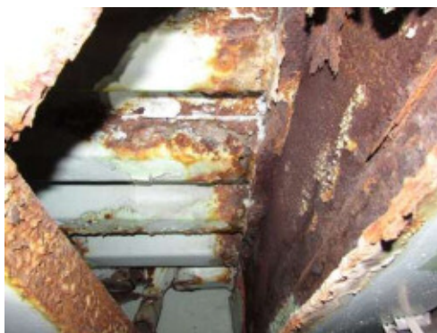
写真-1 横断歩道橋の損傷（桁下）
