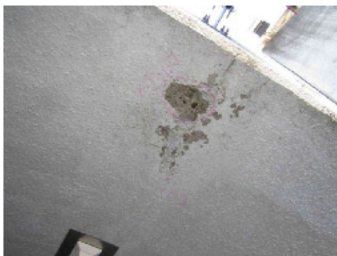
写真-2 大型カルバートの損傷
