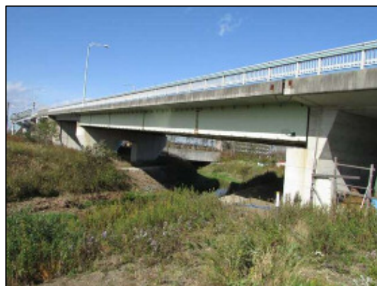
写真-6 かわぞえ跨線橋（複合橋）
