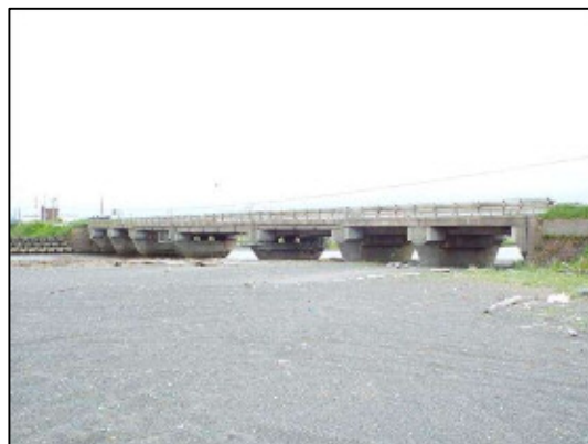
写真-2 勇払橋（橋長85.7m） 昭和28年供用開始（71年経過）
