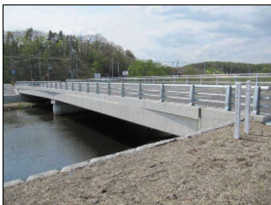
写真-3 新植苗橋（PC橋）
