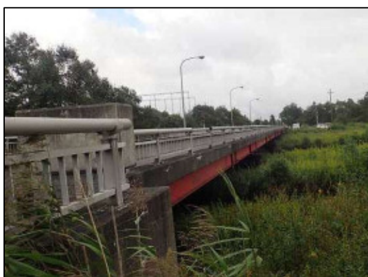
写真-1 夕振大橋（橋長98.4m） 昭和44年供用開始（55年経過）
