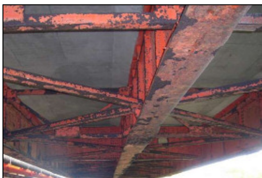
写真-11 鋼桁塗装塗替え前
