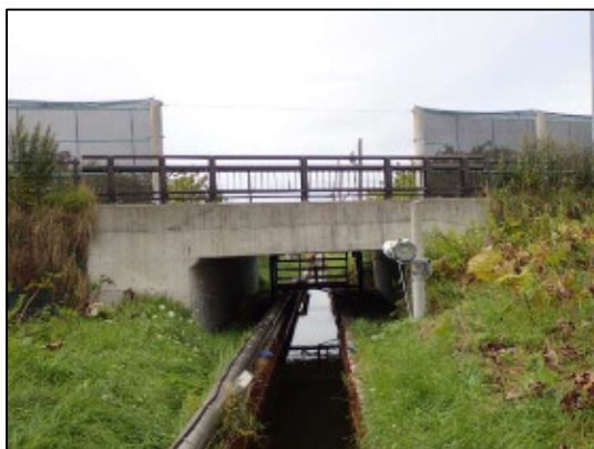
写真-5 王子橋（RC橋）
