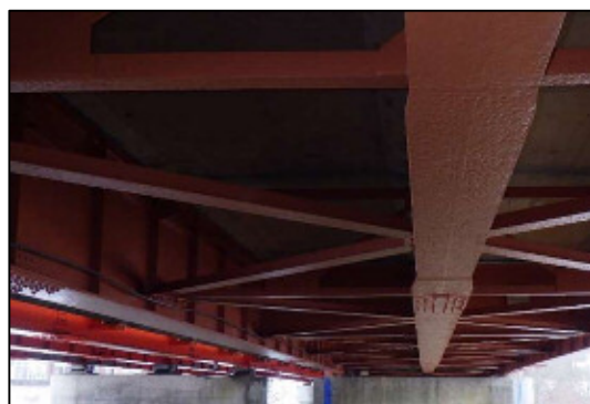
写真-12 鋼桁塗装塗替え後
