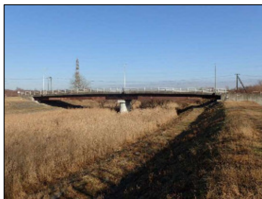
写真-4 新川3号橋（鋼橋）
