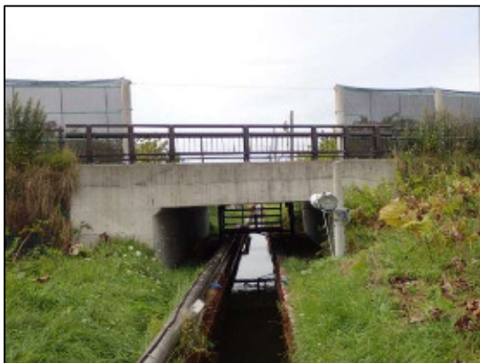
写真-5 王子橋 (RC橋)
