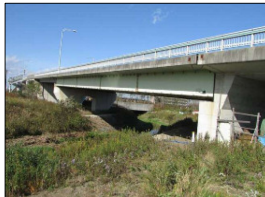
写真-6 かわぞえ跨線橋 (複合橋)
