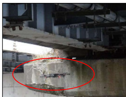
写真-14 新技術による点検 (参考例：ドローン使用)
