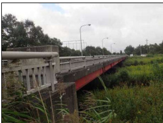
写真-1 夕振大橋 (橋長98.4m) 昭和44年供用開始 (53年経過)
