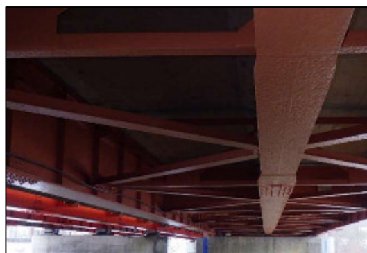
写真-12 鋼桁塗装塗替え後
