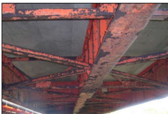
写真-11 鋼桁塗装塗替え前
