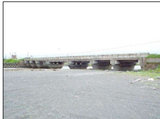
写真-2 勇払橋 (橋長85.7m) 昭和28年供用開始 (69年経過)
