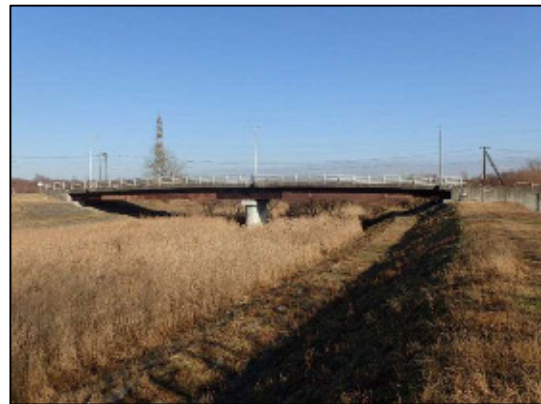
写真-4 新川3号橋 (鋼橋)
