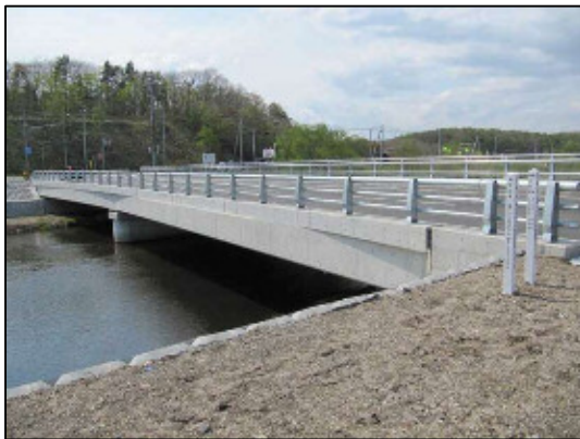
写真-3 新植苗橋 (PC橋)
