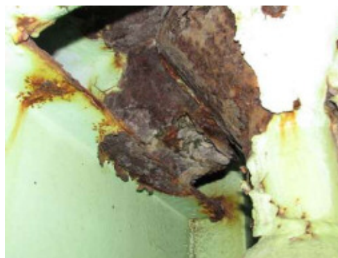
写真-1 横断歩道橋の損傷（桁下）
