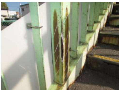
写真-4 横断歩道橋の損傷（橋面）
