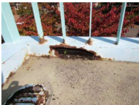
写真-4 横断歩道橋の損傷（橋面）
