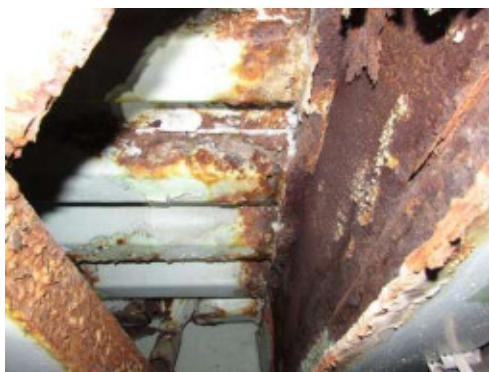
写真-1 横断歩道橋の損傷（桁下）
