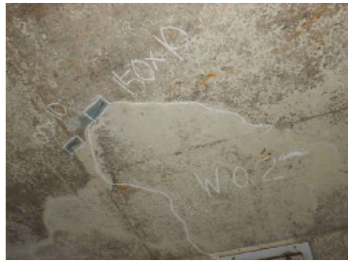
写真-2 大型カルバートの損傷
