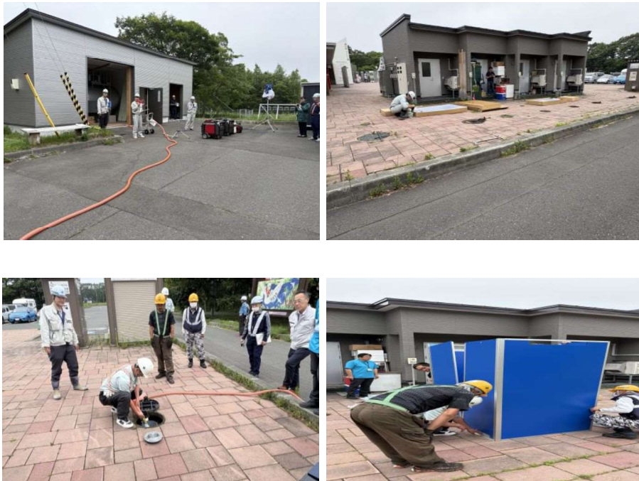
図 9-3 マンホールトイレの使用・操作・組立て方法の確認
