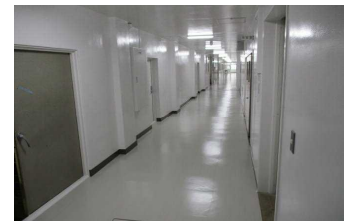
明るく生まれ変わった1階廊下
