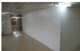
1階保健室前トイレ工事
