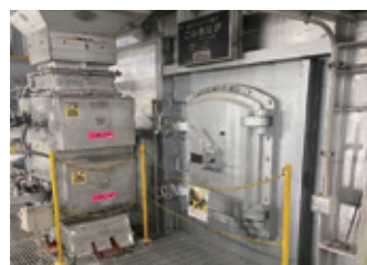
③ 焼却炉 850℃～950℃の高い温度で、ごみを燃やします。
