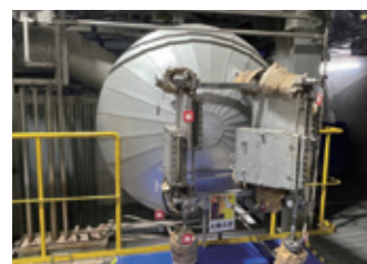
④ ボイラ ごみを燃やして発生する熱を使って、蒸気をつくります。
