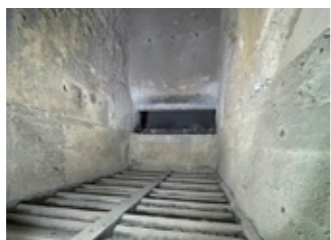
③ 焼却炉 850℃～950℃の高い温度で、ごみを燃やします。
