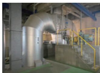
⑧ 誘引通風機 排ガスを、えんとつに送るための機械です。
