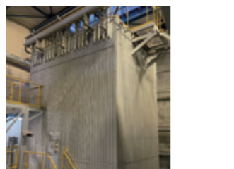
⑦ ろ過式集じん器 排ガスにふくまれるちりや、有害物を取りのぞきます。
