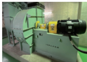
⑩ 押込送風機 ごみを燃やすために必要な空気を、焼却炉へ送る機械です。
