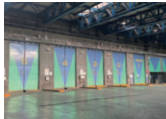
① プラットホーム 集められた燃やせるごみは、ここから入れます。
