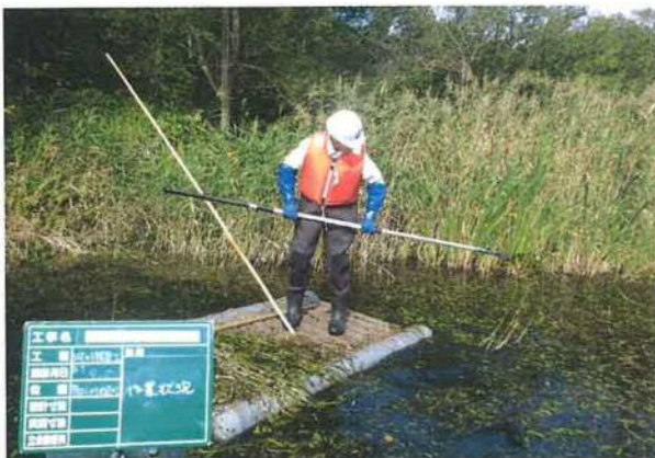
【作業状況①】
