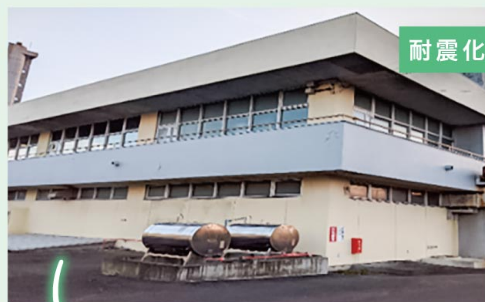
西町下水処理センター
