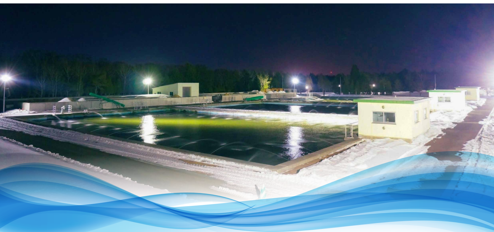
写真：高丘浄水場ろ過池
