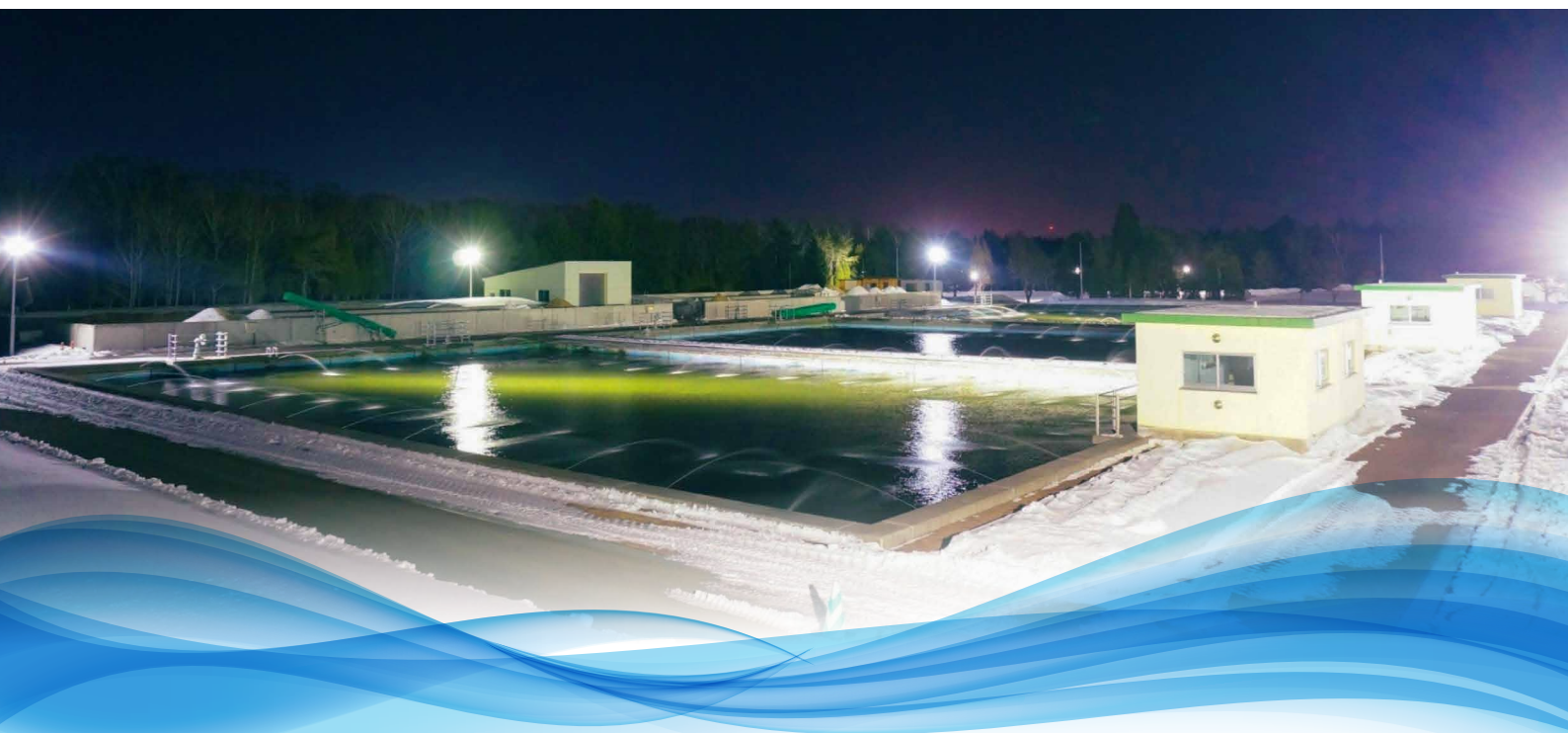
写真：高丘浄水場ろ過池
