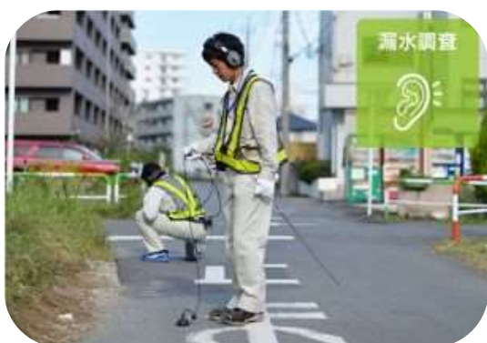
漏水探知機による調査
