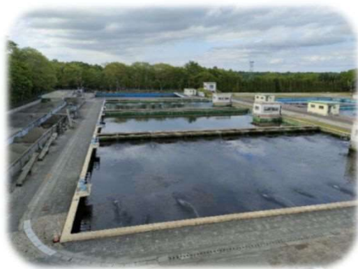
1～3号緩速ろ過池
