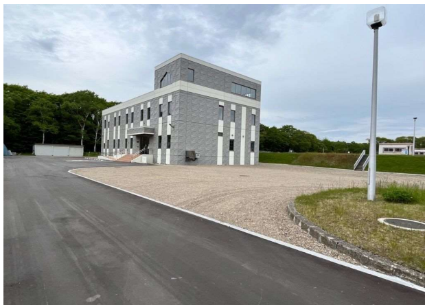
高丘浄水場（場内整備完了）
