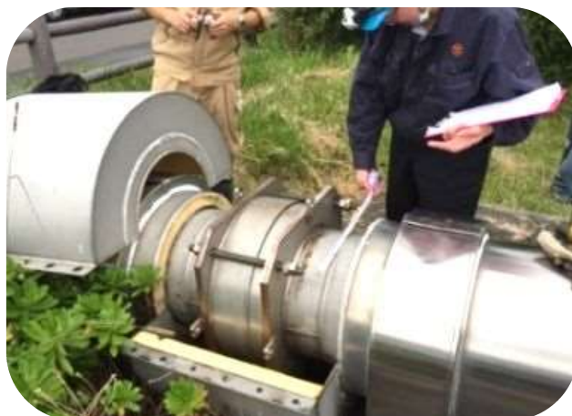
管路の点検作業の様子
