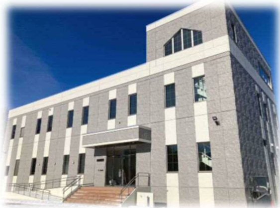
高丘浄水場新管理棟
