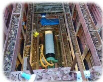
配水本管改良工事
