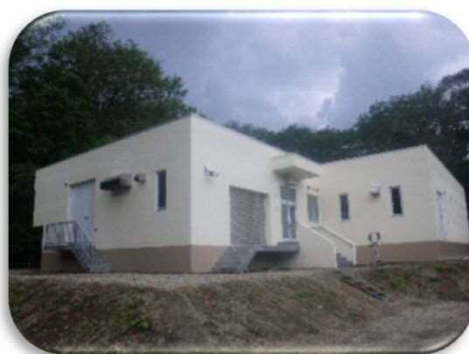
勇振ポンプ場
