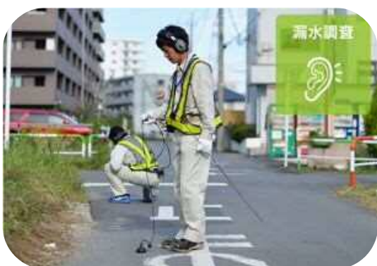
漏水探知機による調査
