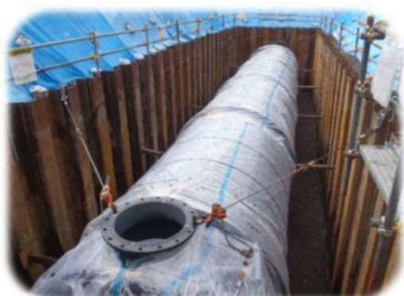
緊急貯水槽設置状況
